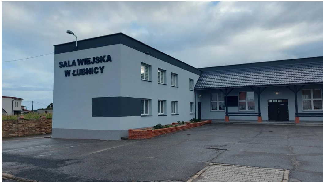
Ocieplanie ścian Sali w Łubnicy
