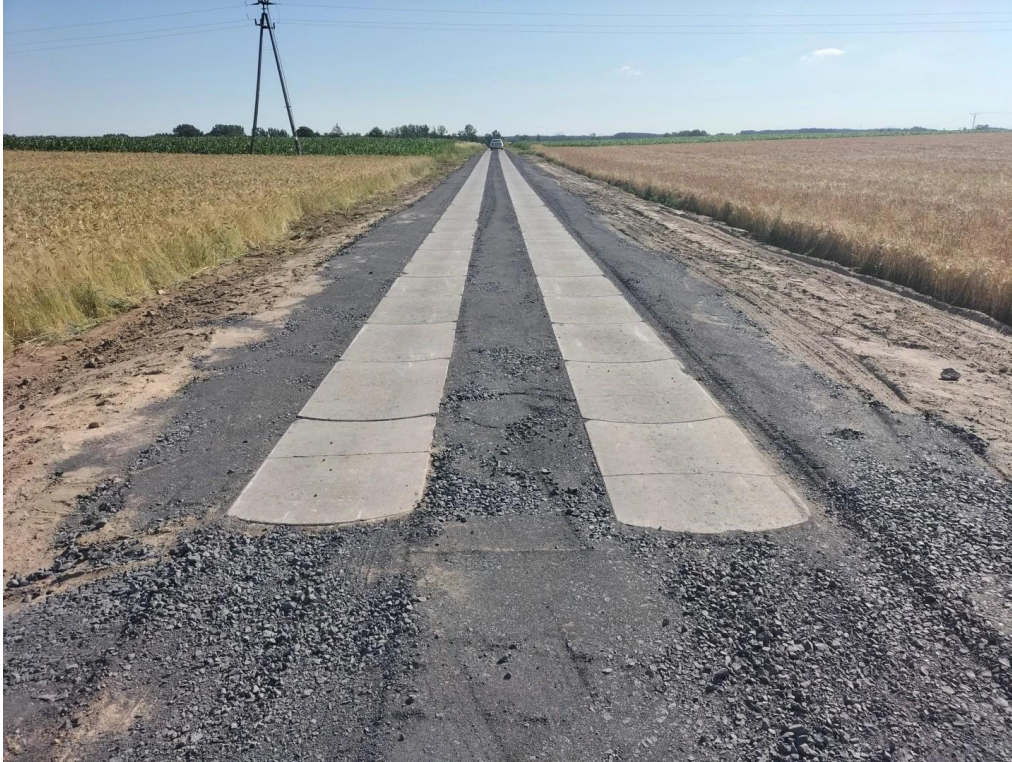
Remont drogi w Piotrowie Wielkim
